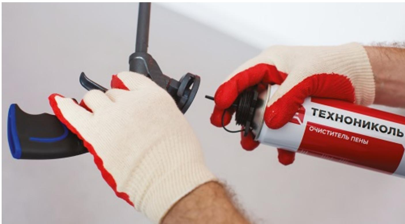
После завершения работ необходимо тщательно очистить пистолет с помощью очистителя монтажной пены ТЕХНОНИКОЛЬ.
