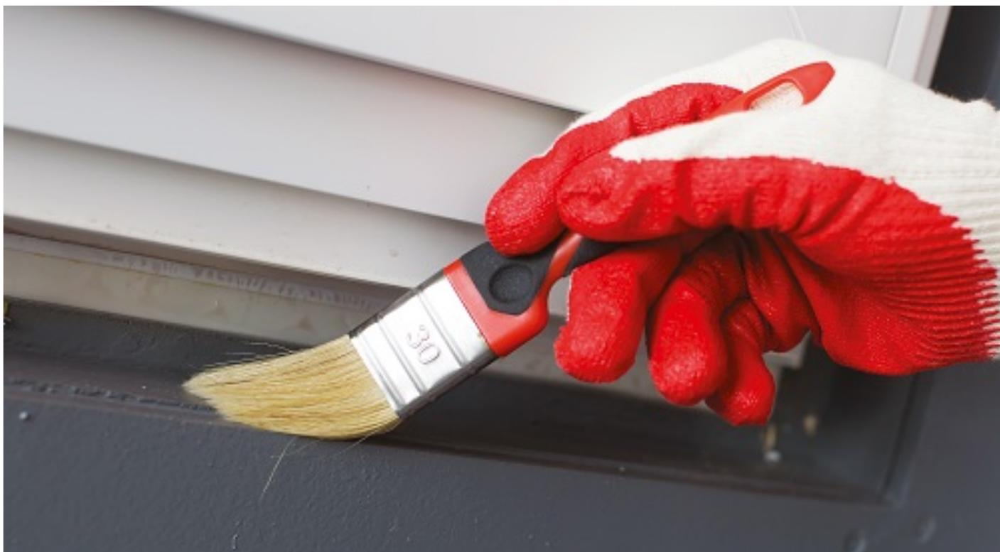
Очистите поверхность при помощи мягкой щетки или кисти. Для удаления жировых загрязнений используйте ветошь, смоченную очистителем монтажной пены ТЕХНОНИКОЛЬ.
