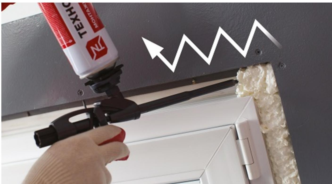
Заполняйте швы равномерными W - образными движениями, оставляя для расширения пены примерно 1/3 объема заполняемой полости.
